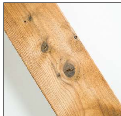
Praskliny v sucích jsou povoleny
