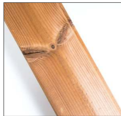
Praskliny v sucích jsou povoleny
