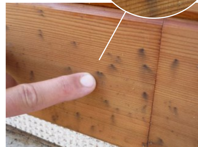
Metalické špony na dřevě od řezání kovů v jeho blízkosti a následná korozivní reakce kovů se dřevem ve formě tmavých skvrn.
