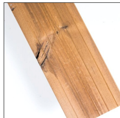
Praskliny kolem suků jsou povoleny
