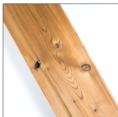
Malé otvory po vypadlých sucích jsou povoleny
