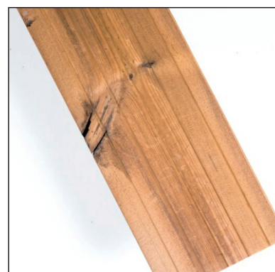
Praskliny kolem suků jsou povoleny
