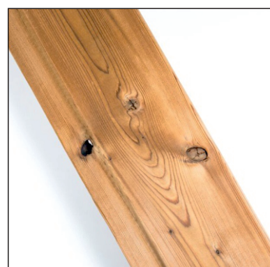
Malé otvory po vypadlých sucích jsou povoleny
