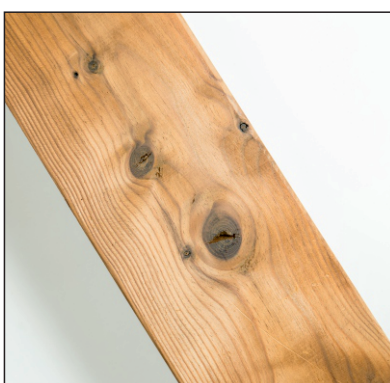
Praskliny v sucích jsou povoleny
